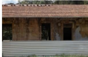
A histórica Estação de Engenheiro Corrêa, em Ouro Preto, avança significativamente em seu processo de restauração, entrando em uma nova e importante fase. Após as etapas iniciais de limpeza e cercamento da área, foi realizado o escoramento completo da estrutura, para garantir a integridade das paredes. Um importante trabalho realizado em seguida foi o reforço estrutural das fundações para dar estabilidade a todo o prédio.
