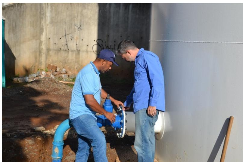
Segundo Sidney Costa, diretor adjunto da autarquia, esse equipamento está passando por várias etapas de testes. "Estamos alimentando o reservatório de acordo com os procedimentos técnicos. Neste momento o reservatório passa pelo teste da estanqueidade (teste para verificar vazamentos). A nossa expectativa é concluir todo processo até sexta-feira dia 21 de abril, disse o diretor adjunto.
