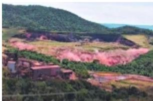
O Ministério Público Federal (MPF) pede a descaracterização da barragem Água Fria, que fica em Ouro Preto, região Central de Minas Gerais, e pertence à empresa Topázio Imperial Mineração. Conforme o órgão, a estrutura, foi construída com alteamento a montante, estilo de construção presente nas barragens que romperam em Mariana, em novembro de 2015, e Brumadinho, em janeiro de 2019.
