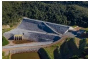
A Vale iniciou as obras para ampliar a capacidade de vazão da Estrutura de Contenção a Jusante (ECJ) da barragem B3/B4, em Macacos, no município de Nova Lima (MG). A mineradora construirá três túneis para reduzir o volume de água acumulada na estrutura em períodos de chuva intensa, como as ocorridas em janeiro deste ano.
