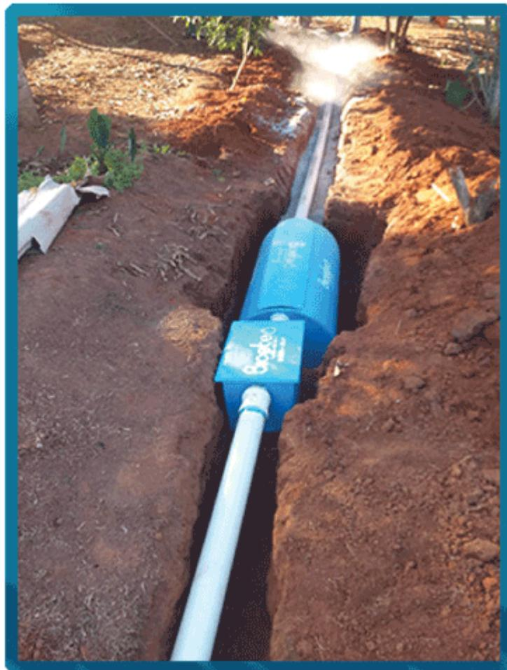
O sistema bioete® utiliza para este fim, reatores no qual o próprio meio de suporte funciona como fluxo em pistão para o desenvolvimento microbiano em seu interior servindo para o desenvolvimento do biofilme onde os compostos contaminantes são adsorvidos pela parede interna do meio de suporte e assim fornecem suprimento para a digestão celular que ocorre ainda no interior das peças do suporte.
